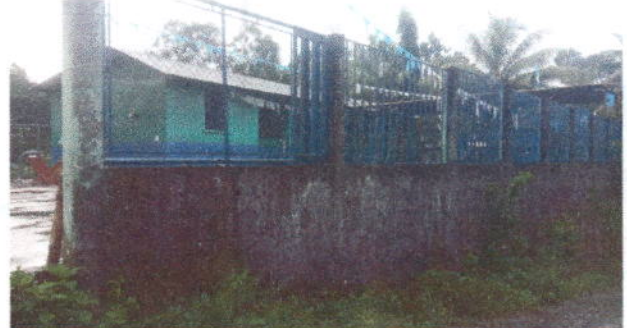
Foto 4: Pintura en muros exteriores e interiores
