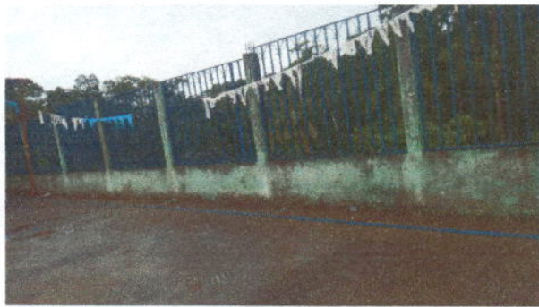
Foto 5: Pintura en muros exteriores e interiores
