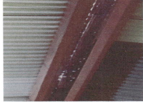
Foto 2: Sustrucción de capote para lamina troquelada.
